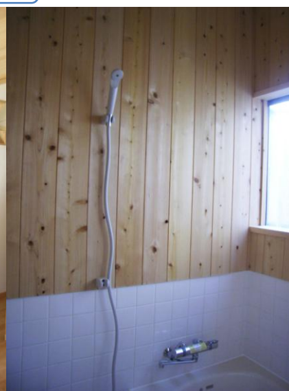
浴室ヒノキ板張り
