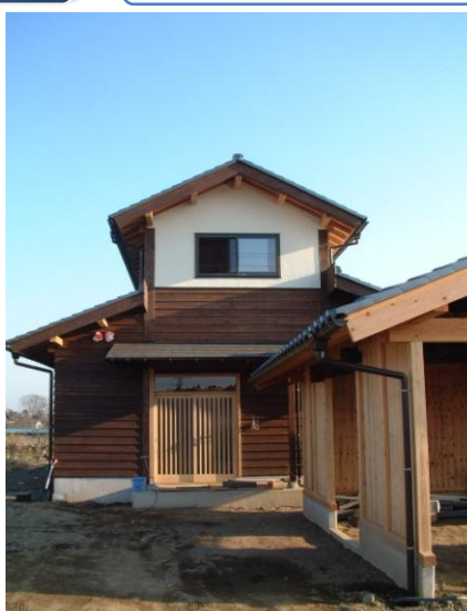
板張りの外観
